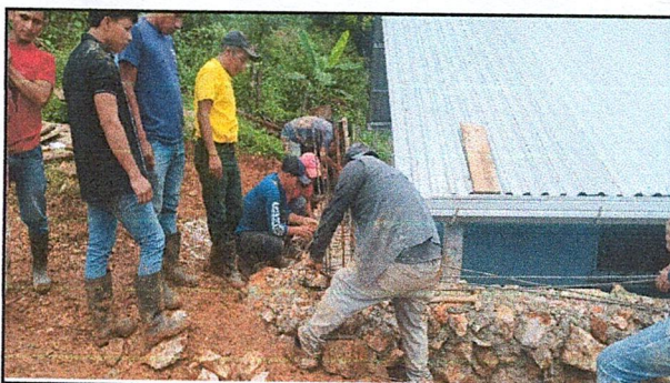
Foto 16: Reparación de muro de contención
