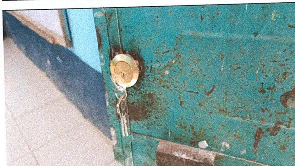
FOTO 4: REPARACIÓN DE PUERTAS
