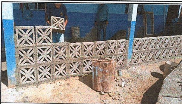
Foto 14: Colocación de celosía el contorno del corredor del modulo de la escuela.
