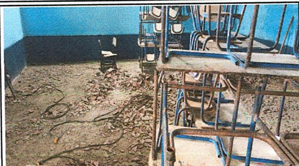
Foto 7: SUSTITUCIÓN DE PISO
