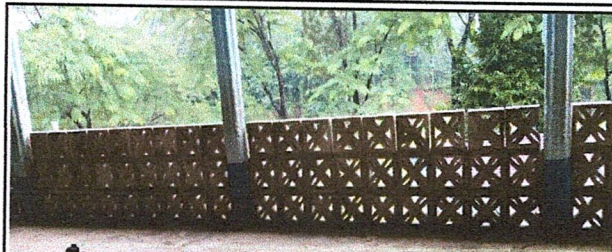
Foto 13: Colocación de celosía el contorno del corredor del modulo de la escuela
