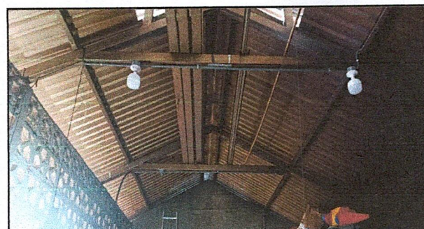
Foto 12: REPARACION DEL SISTEMA ELECTRICO
